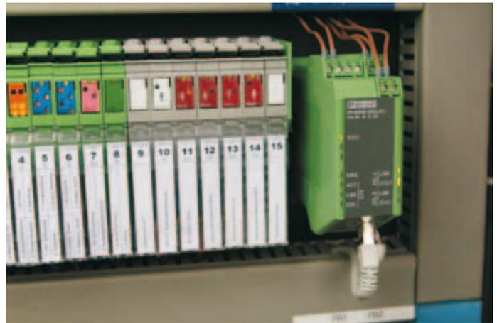
Bild 3: Die SHDSL-Modems erfordern keine Netzwerk-Konfiguration
