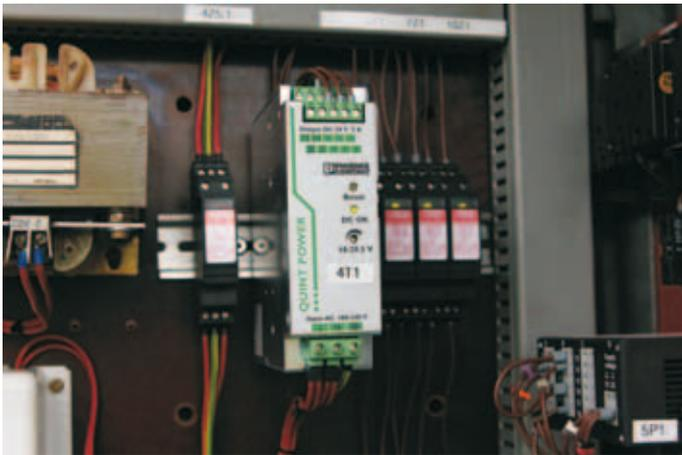
Bild 2: Quint-Stromversorgungen liefern aufgrund von SFB Technology und Power Boost deutlich mehr als den Nennstrom
