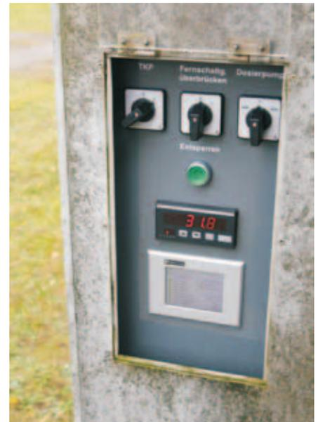
Bild 4: Das Web-Panel eignet sich für anspruchsvolle Aufgaben mit erweitertem Temperaturbereich
