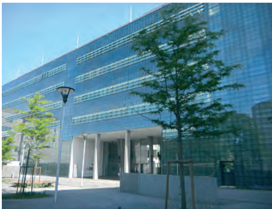
Neues Chemiegebäude Stremayrgasse 9
