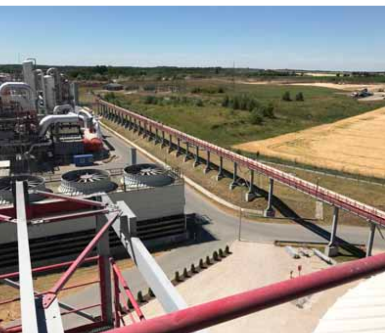
Kräftiger Luftstrom statt Transportrollen lässt das innovative Band samt Fördergut über weite Strecken schweben.
