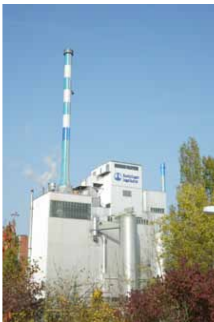
Das firmeneigene Kraftwerk in Ingelheim betreibt Boehringer seit 2004 mit Biomasse.
