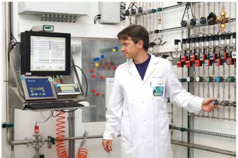
Dank gelungener Umstrukturierung: Einzigartig kurze Lieferzeiten bei Spezialgasgemisch-Portfolio.
