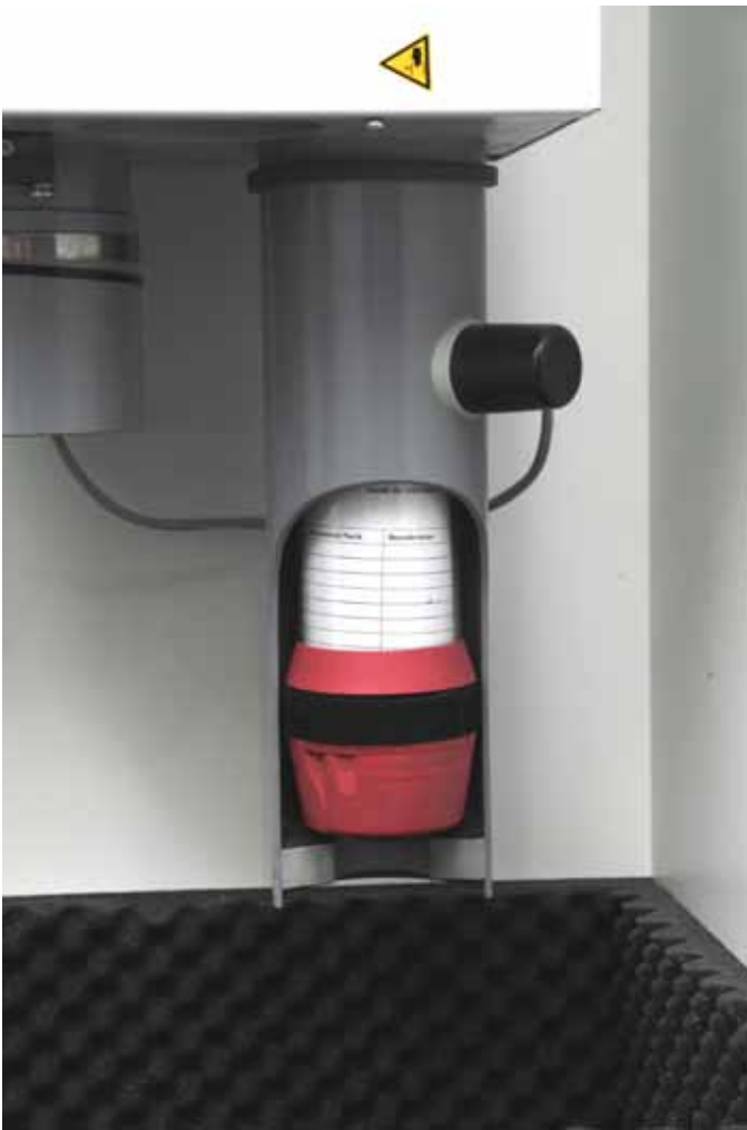
Modernste Rohrpostanlage Europas: Die Rohrbomben erreichen bis zu 40 km/h und garantieren auch dank integrierter Mikrochips höchstmögliche Sicherheit.
