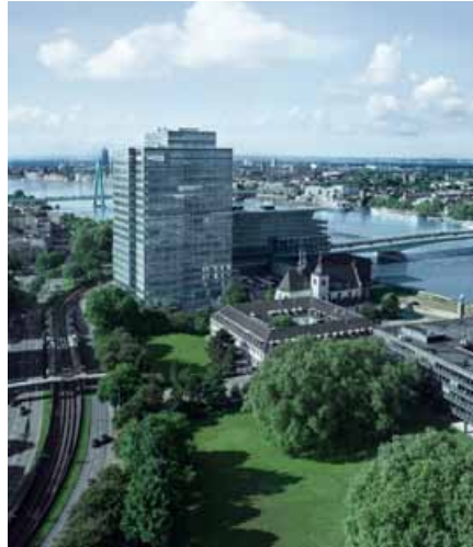
Der Spezialchemie-Konzern steuert seine weltweiten Geschäfte vom Kölner LANXESS Tower aus.
