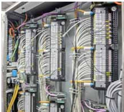
Bild 3: Die patentierte Abschaltfunktion ist bei diesen Ventilen mit einem zweiten Anschluss realisiert, über den der Stromkreis der Magnetspule unterbrochen werden kann.
